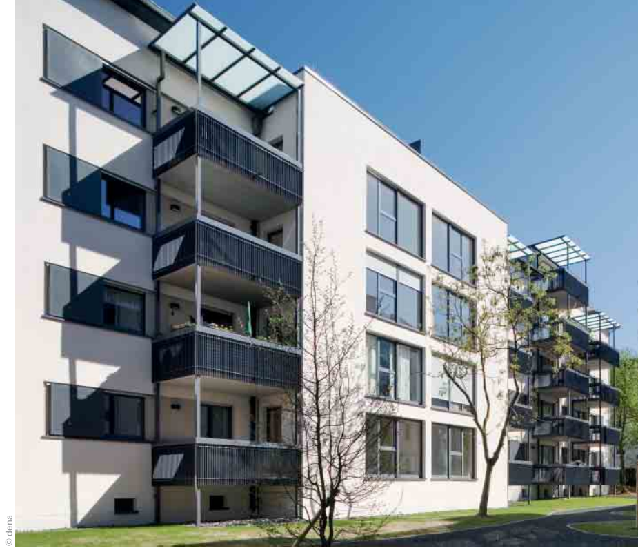
dena-Niedrigenergiehaus Darmstadt nach Sanierung: Das Mehrfamilienhaus von 1949, das im dena-Modellvorhaben „Niedrigenergiehaus im Bestand“ hocheffizient saniert wurde, überzeugt mit 97 Prozent Energieeinsparung nach der Sanierung.
